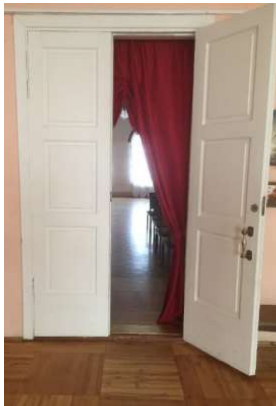
Фото №12 – Дверь №5 (из пом.№8)
