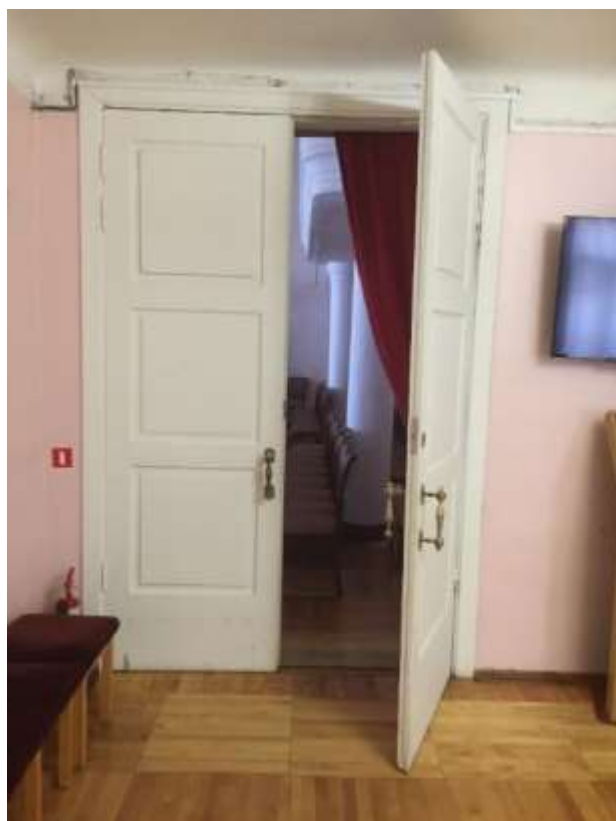
Фото №11 – Дверь №7 (из пом.№2)
