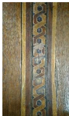
Фото 13. Фрагмент сиденья. До реставрации.
